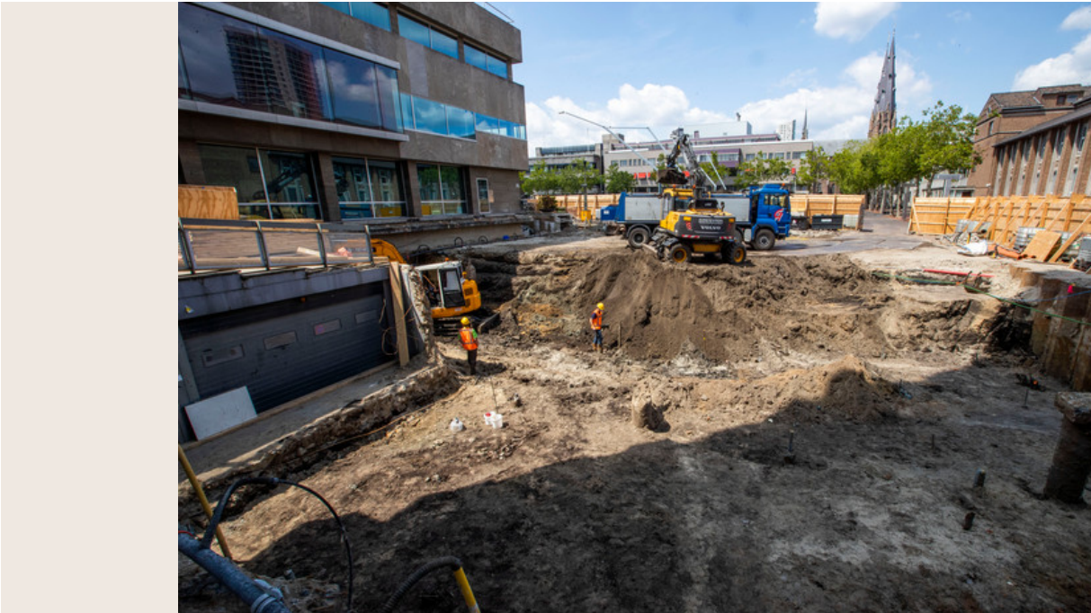
Grondwerkzaamheden voor de aanleg van de nieuwe ingang van het Stadhuis in Eindhoven. Voor het afvoeren van deze grond moet voortaan een onderzoek aantonen dat die niet vervuild is met zogenaamde PFAS/PFOS-stoffen.
