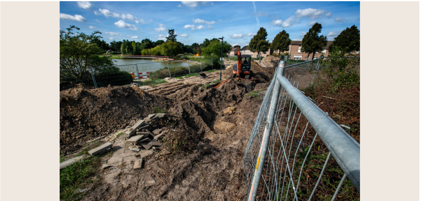
Werkzaamheden aan de stadsverwarming in park Brouwhuis in Helmond. Als een deel van de grond het bouwterrein verlaat is een PFAS-vrije verklaring en dus onderzoek nodig. © Fotopersburo van de Meulenhof BV
