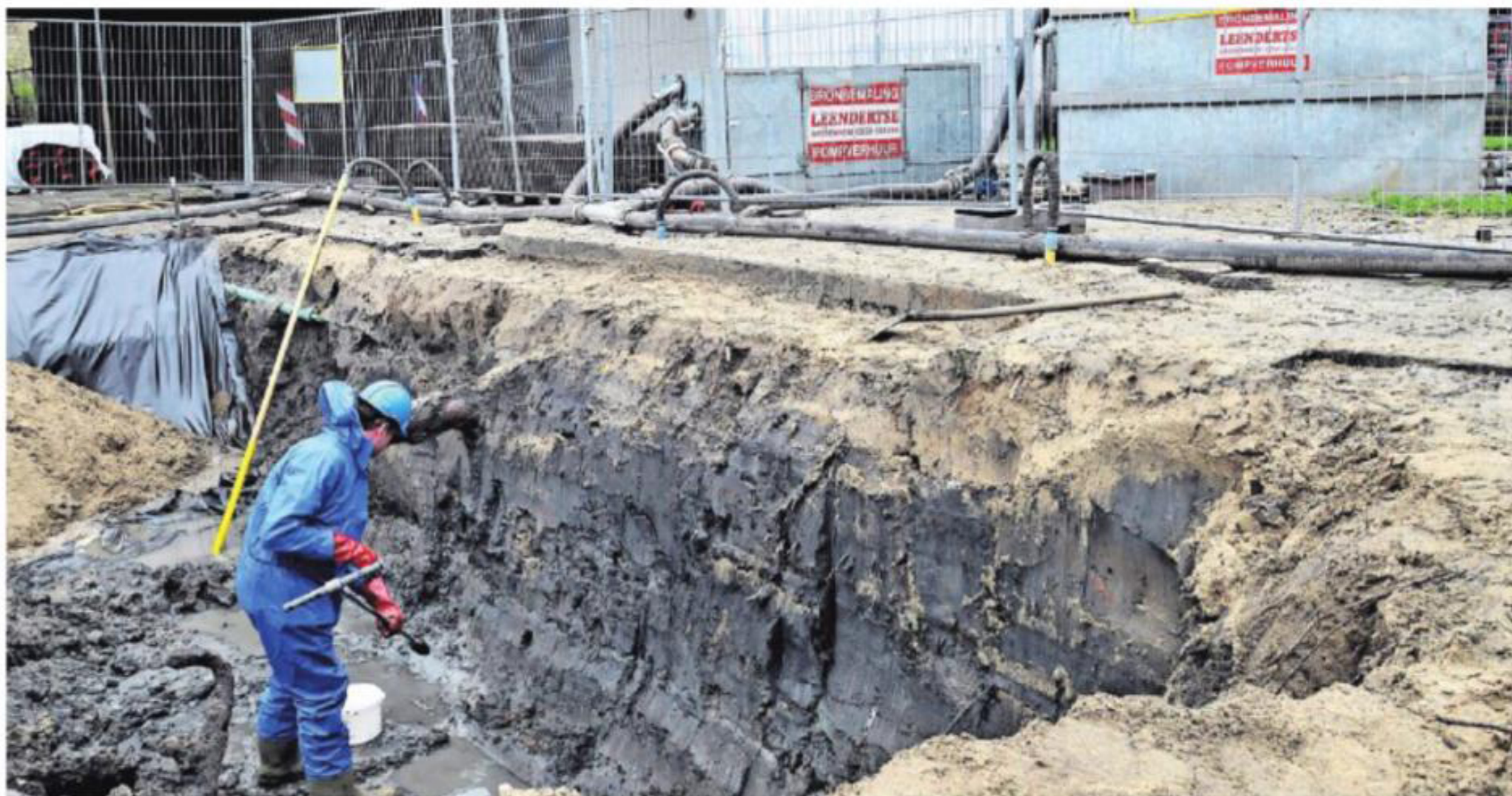
▲ Afgraving van vervuilde grond in Delft. FOTO BURO FRED NIJS
